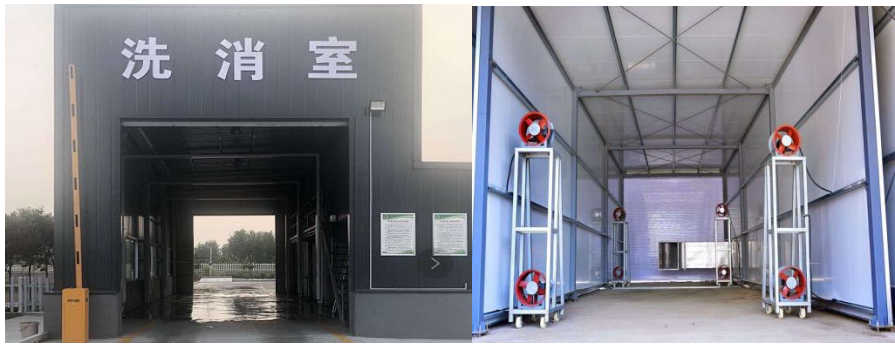
（a）封闭式车辆洗消中心 （b）烘干房
